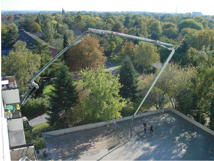
Abb. 1: Betonage über Pumpe
